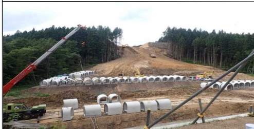
小国地区～岩井沢地区（現在施工箇所）
