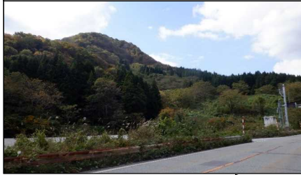
小国トンネル 終点側
