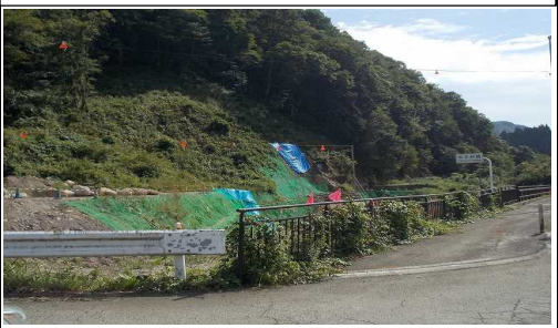
及位地区 (新及位トンネル終点側新庄方向)
