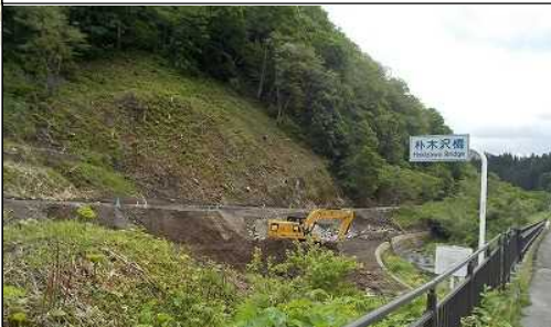
及位地区 (新及位トンネル終点側新庄方向)
