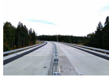
十日町西山中地区(尾花沢方向)
