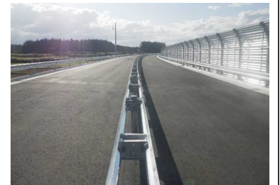
昭和地区(尾花沢方向)
