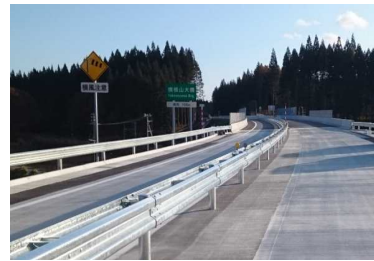
横根山大橋付近(尾花沢方向)
