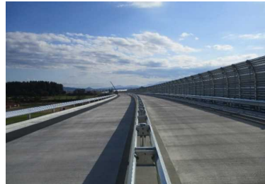
泉田川橋(尾花沢方向)
