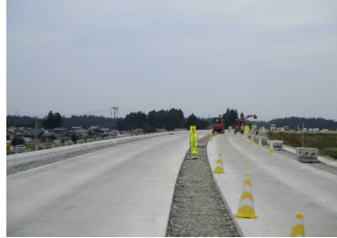
泉田川橋付近(金山方向)
