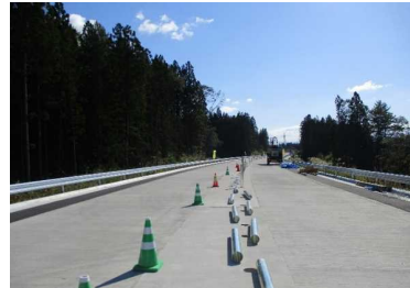
十日町西山中地区(尾花沢方向)
