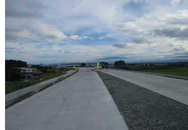
泉田川橋(尾花沢方向)
