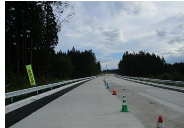
十日町西山中地区(尾花沢方向)
