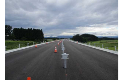
昭和地区(尾花沢方向)
