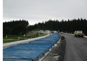
横根山大橋付近(尾花沢方向)
