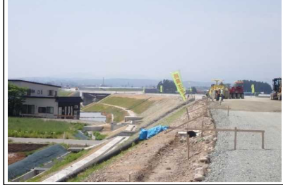
泉田川橋(尾花沢方向)
