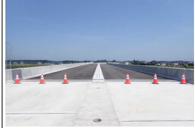
泉田川橋付近(金山方向)
