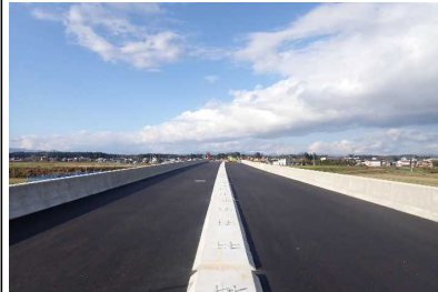
泉田川橋付近(金山方向)
