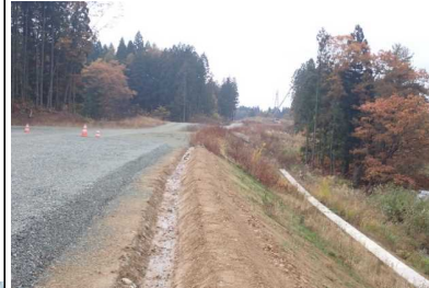
十日町西山中地区(尾花沢方向)
