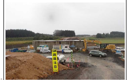
昭和地区(尾花沢方向)
