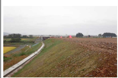
泉田川橋(尾花沢方向)
