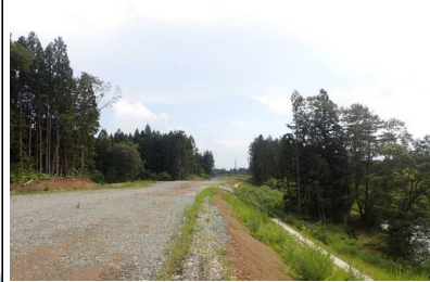
十日町西山中地区(尾花沢方向)
