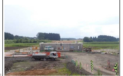
昭和地区(尾花沢方向)
