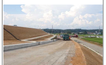
昭和IC橋付近(金山方向)
