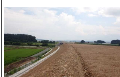
泉田川橋(尾花沢方向)
