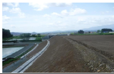
泉田川橋(尾花沢方向)
