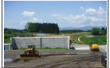
昭和地区(尾花沢方向)
