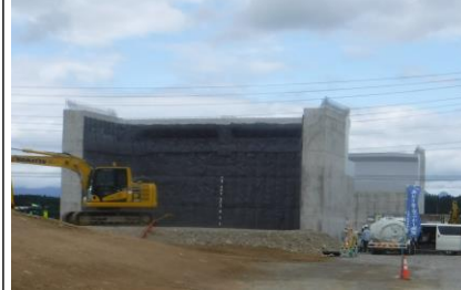
昭和IC橋付近(金山方面)
