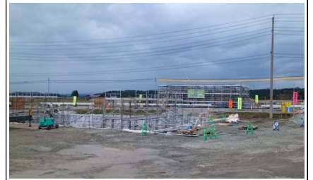
昭和IC橋付近 (金山方面)
