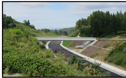
村山跨道橋(新庄方向)
