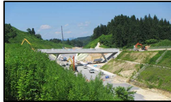
村山跨道橋(新庄方向)
