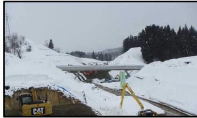
村山跨道橋(新庄方向)
