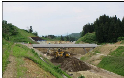
村山跨道橋(新庄方向)
