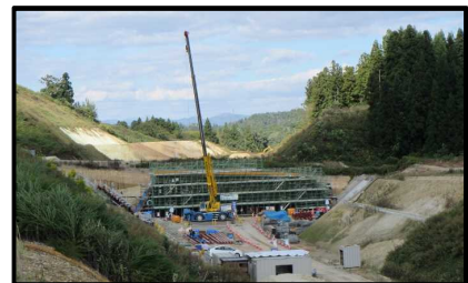
村山跨道橋(新庄方向)
