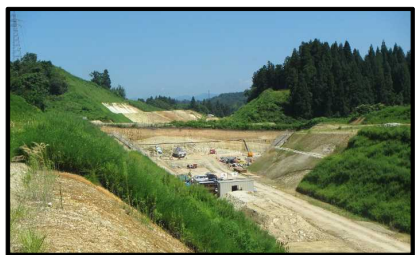
村山跨道橋(新庄方面)
