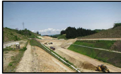
村山跨道橋(新庄方面)
