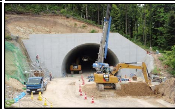
村山トンネル(終点側坑口)
