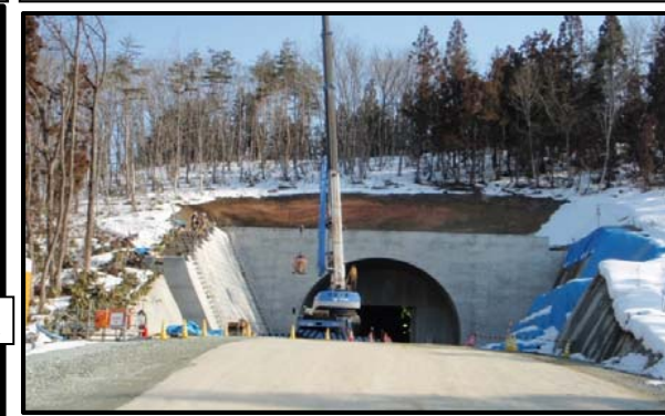
村山トンネル
