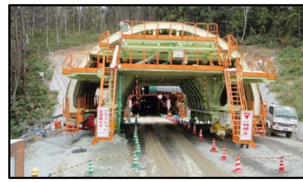
村山トンネル
