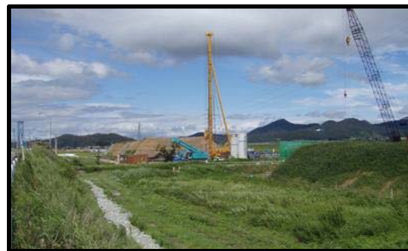
西郷高架橋(仮称)(新庄方向)
