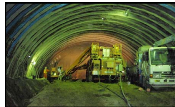
村山トンネル
