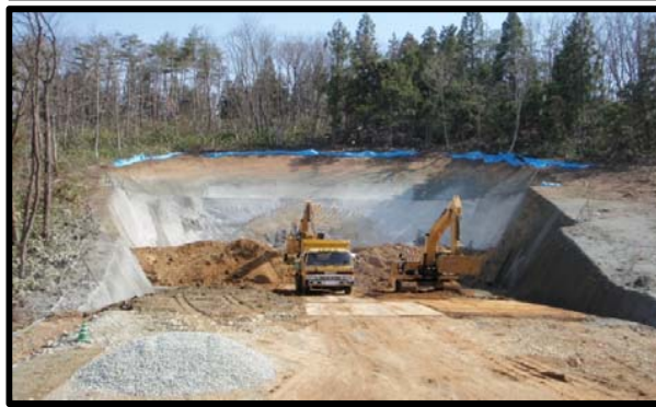
村山トンネル(山形側)
