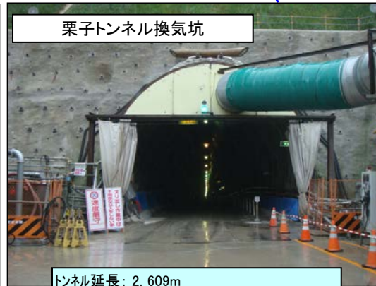
トンネル延長: 2,609m 掘削延長: (326.4m)+709.0m=1035.4m (39.7%) 覆工延長: 0m(0%)
