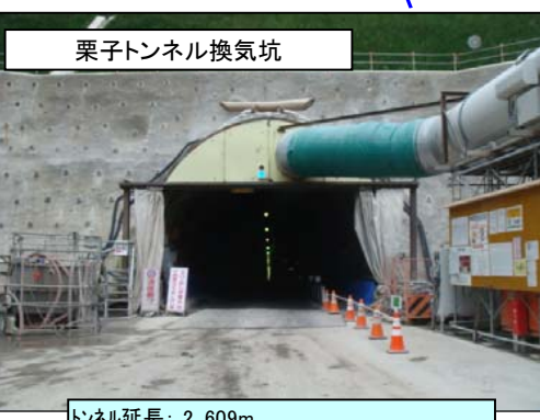
トンネル延長：2,609m 掘削延長：(326.4m)+381.6m=708.0m(27.1%) 覆工延長：0m(0%)
