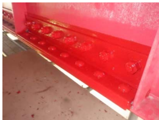
写真4-6 【対策】鋼桁補強工
