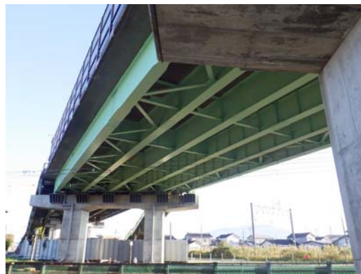
写真4-7 【全景】御成跨線橋
