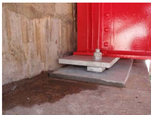
写真4-21 【対策】支承交換
