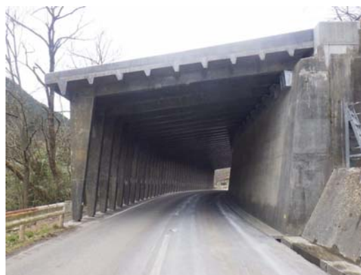
写真4-16 【全景】 湯温海スノーシェッド
