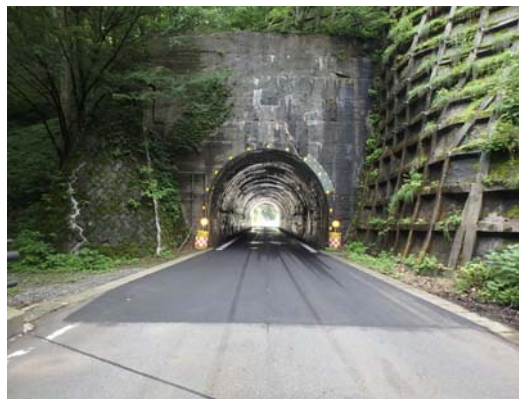
写真4-13 【全景】青沢第一隧道
