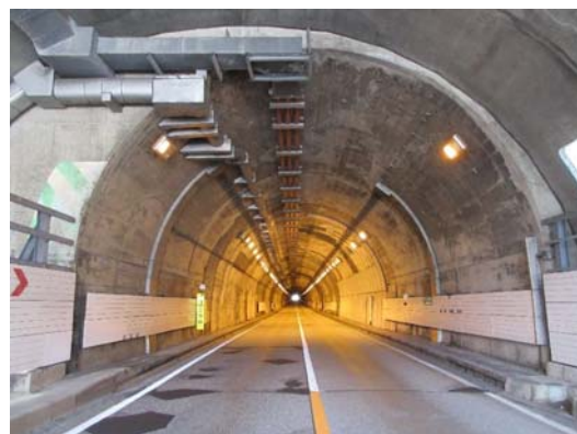
写真4-10 【全景】湯殿山トンネル
