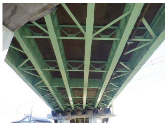
写真4-9 【対策】塗替塗装
