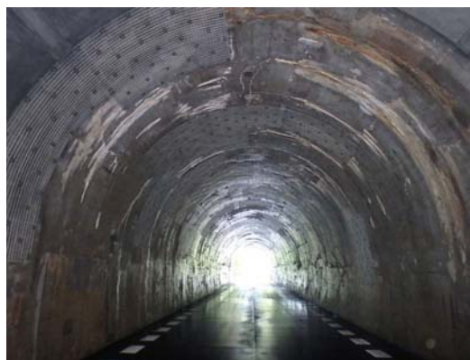
写真4-15 【対策】 覆工補強工、断面修復、水抜き孔
