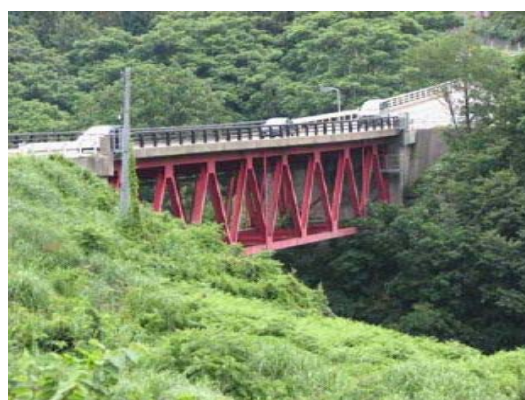
写真4-4 【全景】新間瀬橋
