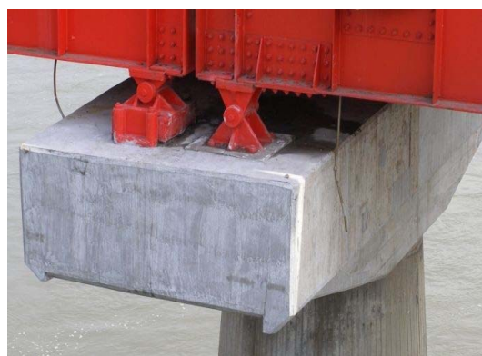
写真4-3 【対策】断面修復
