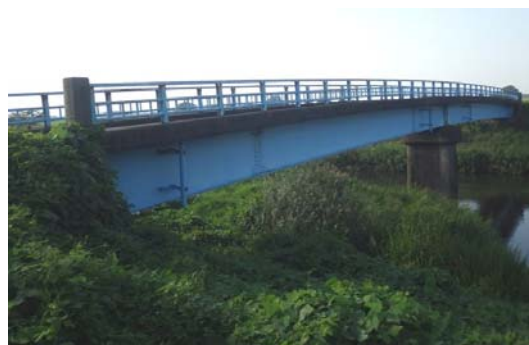
写真4-16 【全景写真】早塚橋
