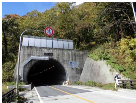
写真4-10 【全景写真】横手トンネル
