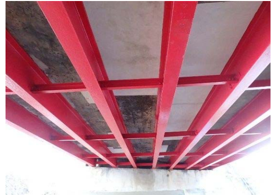
写真4-9 【対策】 床版断面修復、橋面防水、主桁再塗装
