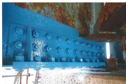
写真4-18 【対策】当て板補強
