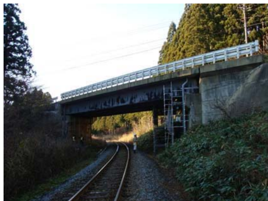
写真4-13 【全景写真】堺田こ線橋
