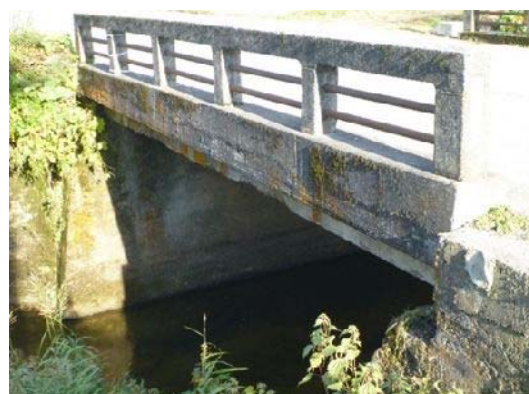
写真4-4 【全景写真】西又橋
