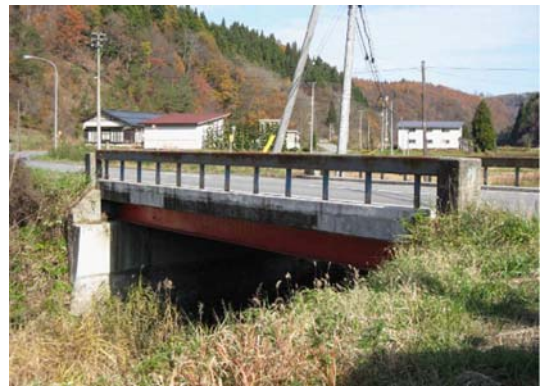
写真4-7 【全景写真】居残沢橋
