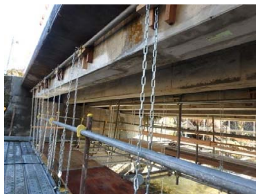
写真4-6 【対策】主桁断面修復
