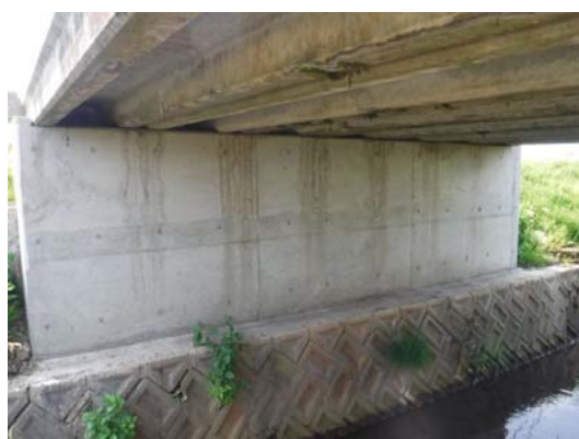
写真4-15 【対策】橋台の新設
