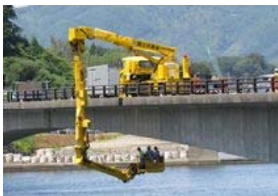
写真3-1 橋梁点検状況
