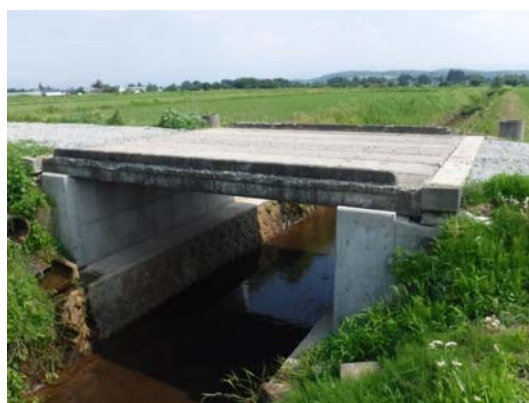
写真4-13 【全景写真】西横道橋
