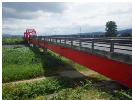
写真4-1 【全景写真】河北橋
