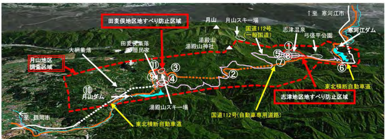
▲地すべり防止区域を通過する国道 112 号月山道路
