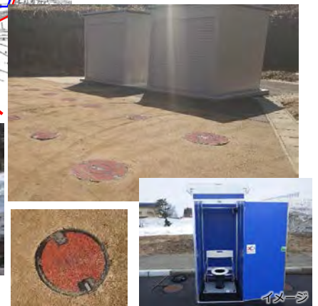
防災倉庫・防災トイレ
