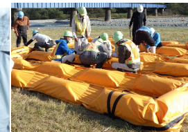
オイルフェンス組立状況
