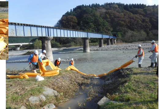
河川でのオイルフェンス設置訓練(半月工法)
