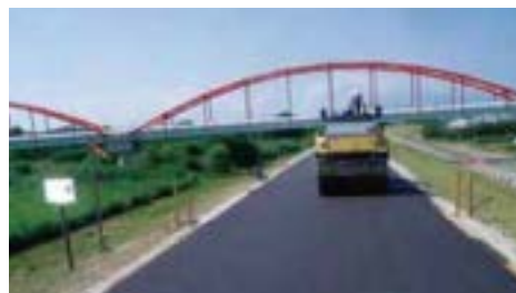
最上川水系須川の事例(堤防天端の保護)
