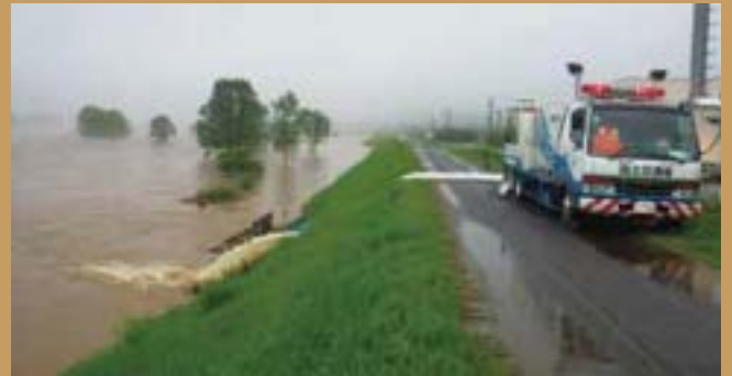
平成26年7月 洪水被害による排水作業
