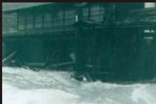
道路の激流による家屋損壊(川西町)
