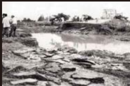
長崎橋手前R112号損壊(中山町)
