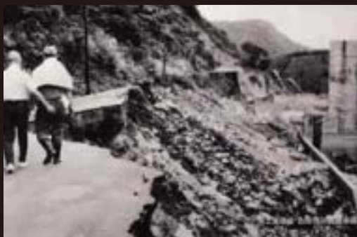
赤芝発電所付近のR113号損壊(小国町)
