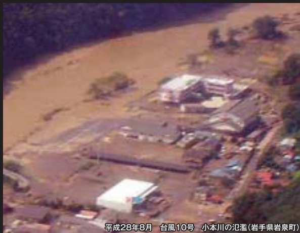
平成28年8月 台風10号 小本川の氾濫(岩手県岩泉町)
