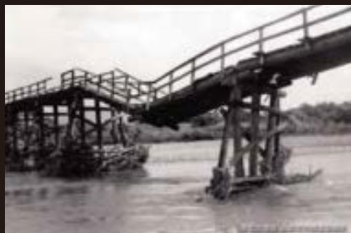
坂水橋(川西町)
