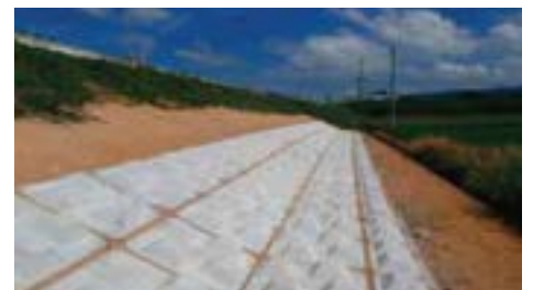
最上川水系元宿川の事例(堤防裏法尻の補強)
