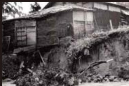
織機川右岸侵食による家屋倒壊(南陽市)
