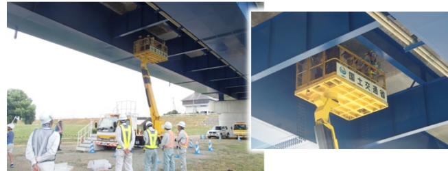
橋梁点検車による点検作業体験
