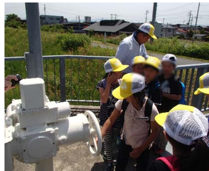
樋管操作体験
