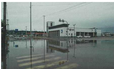
中山町長崎地区浸水状況
