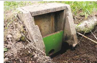
排水柵に調整板を設置した様子
