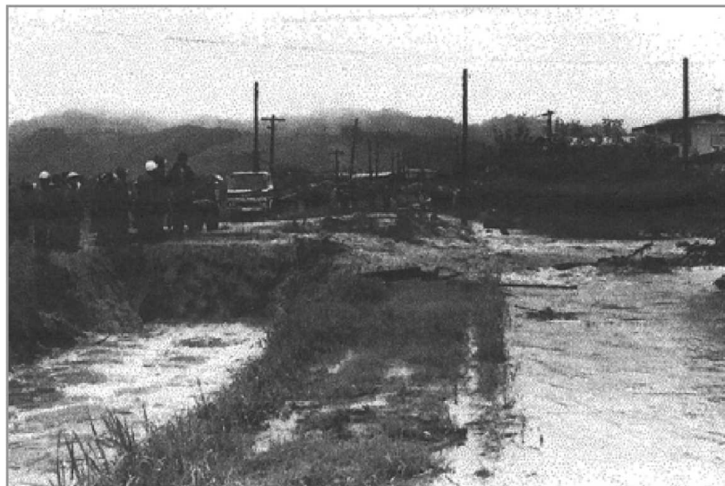
中山町内の流木による河積阻害
