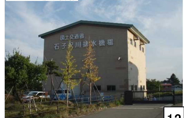
石子沢川排水機場
