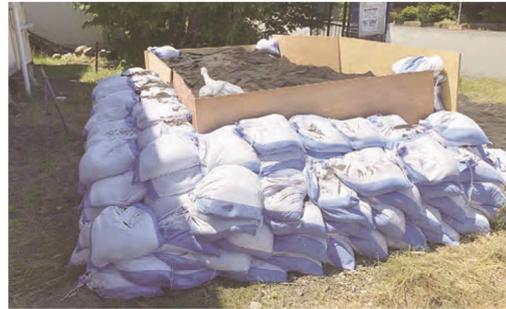
※落合地区に設置した土のうステーション。作成済みの土のう（約500袋）と、土のう用の砕砂を設置しています。
