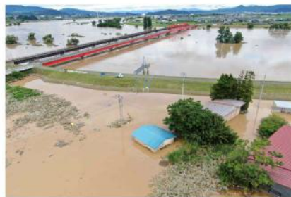
押切地区 河北橋付近 浸水状況
