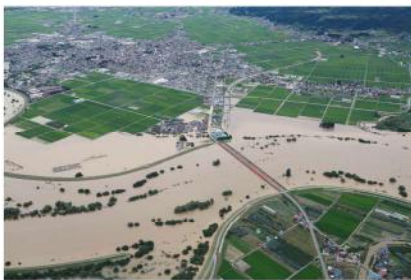
押切地区付近の浸水
