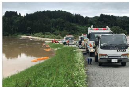
比良地区 排水ポンプ車による排水活動
