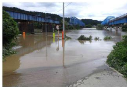
増水による道路への浸水
