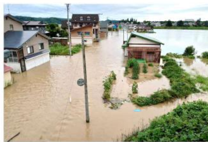
町内の浸水被害
