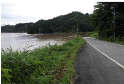
上川左岸 県道大石田畑線実栗屋橋付近の冠水
