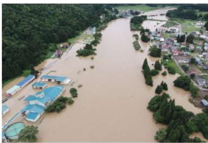
大浦地区の浸水被害
