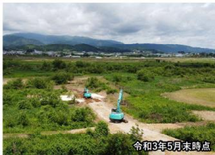
東根市長瀬 河道掘削 工事着手
