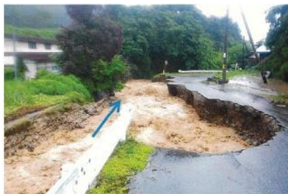
白鷹町滝野 荒砥川 護岸破損
