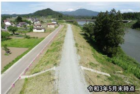
村山市長島 堤防整備 工事着手
