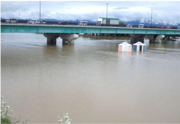
最上川中山緑地公園 高水敷の浸水
