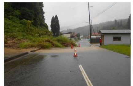
山の内地区の土砂災害
