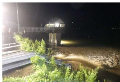
蔵岡地区 内水排除作業 最上川への排水
