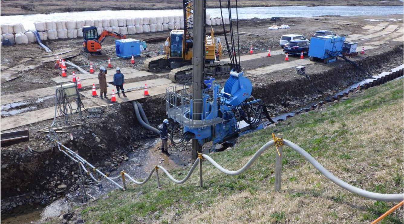
遮水矢板の工事
