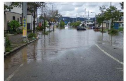
あおば地区 浸水状況
