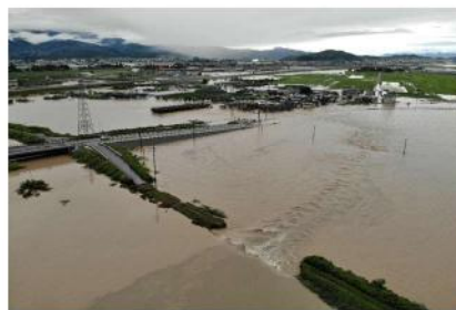
岡嶋地区の浸水被害
