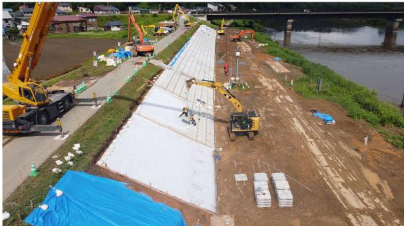
護岸ブロックの工事
