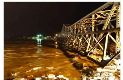
大石田大橋の床版を越える水位と河川ゴミ
