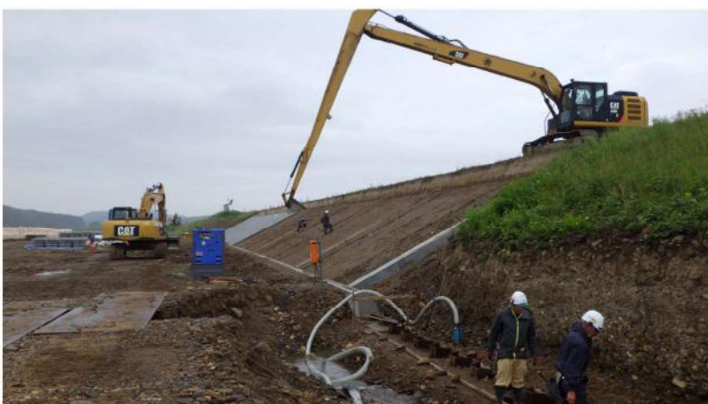
護岸ブロックの工事
