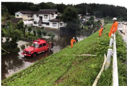
水防団による排水作業
