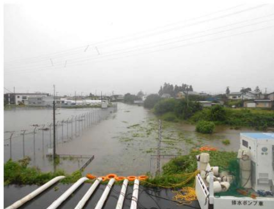
山形市樺沢 王川内水被害状況
