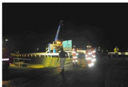
堀内第1樋管 夜を徹しての作業
