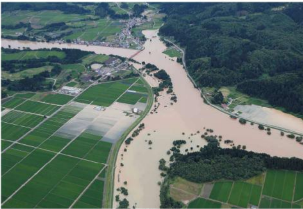
堀内橋付近の浸水
