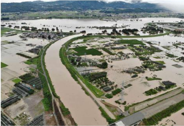
最上川と白水川合流点(岡嶋地区)の浸水被害
