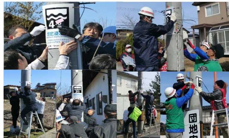
現地案内看板の設置状況
