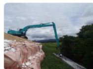
▲ 大型連鎖ブロック設置状況
