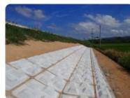
▲ 大型連鎖ブロック設置完了
