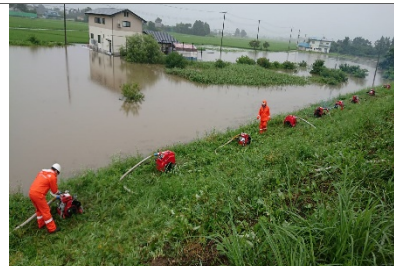
誕生川右岸(洲島地内) 内水被害
