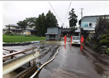
下小松(千松寺地内) 積み土のう工
