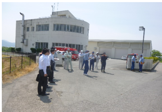
重要水防箇所巡視(大旦川排水機場)
