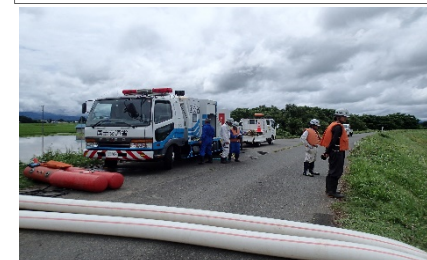
誕生川(洲島地内) 排水作業(国土交通省)
