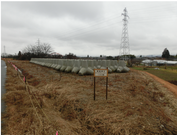
水防資機材の備蓄
