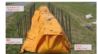
水マット工法
