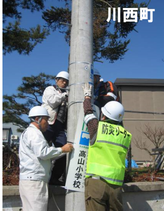
標識の設置状況
