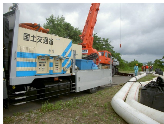
排水ポンプ車設置、排水訓練 (平成 27 年)
