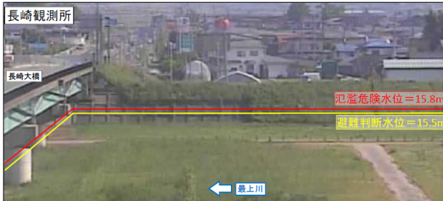
CCTV カメラ基準水位イメージラインの提供
