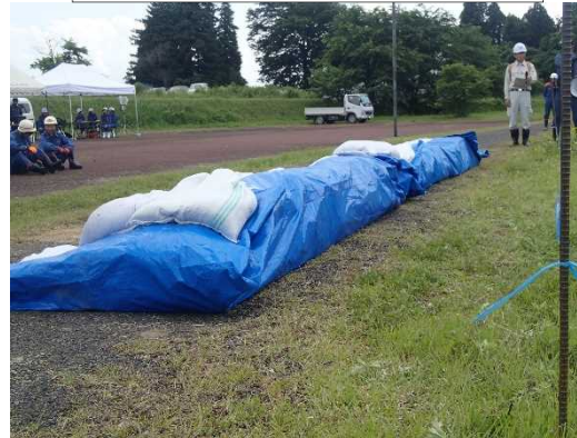
改良積み土のう工法
