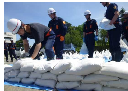
積み土のう工法
