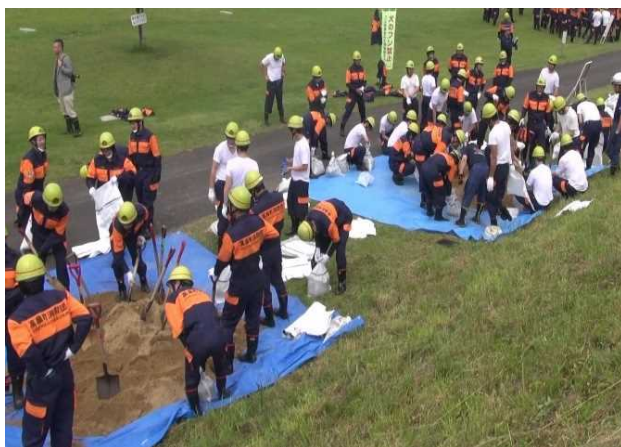
改良積み土のう工法
