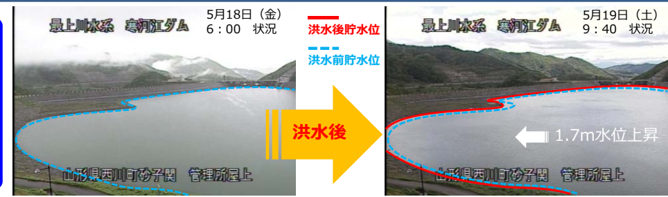
寒河江ダム貯水状況
