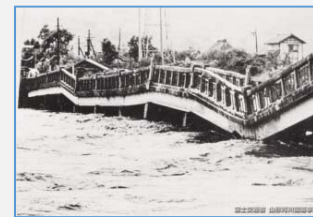
S42羽越水害 被害写真 山形市 門伝橋の崩壊
