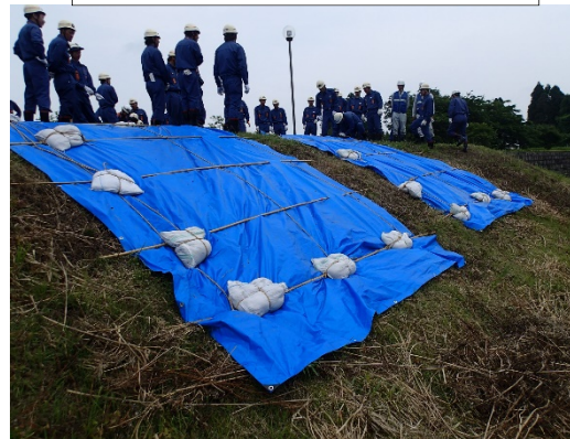
シート張り工法
