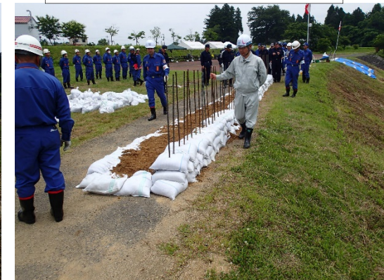
積土のう工法
