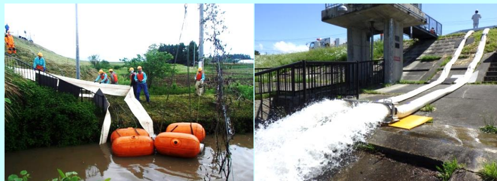
【ポンプの設置】
