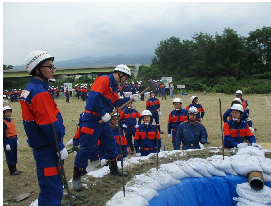
消防団員による月の輪工法訓練
