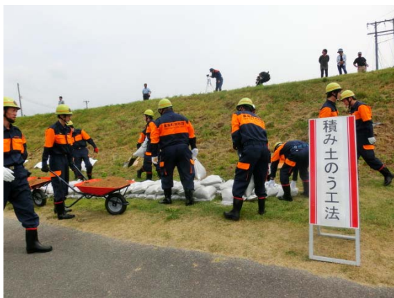
積み土のう工法
