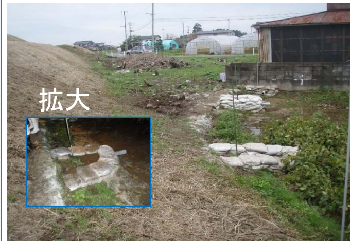
【月の輪工法 3箇所設置】
