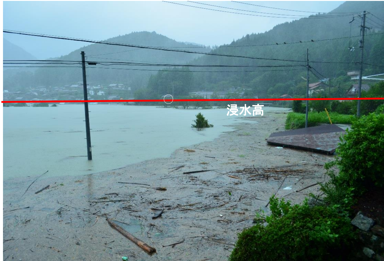
熊野川氾濫により浸水した浅里地区
