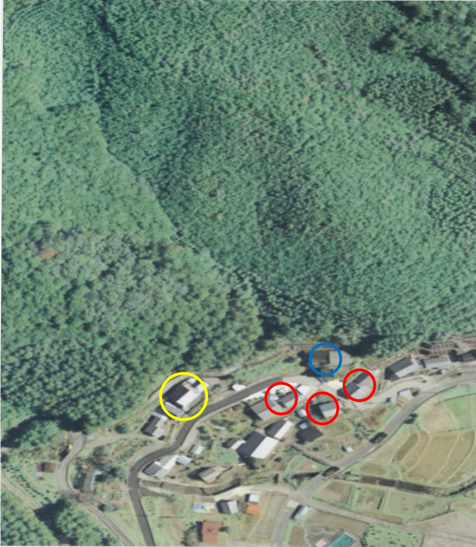
被災前の浅里津呂地地区
