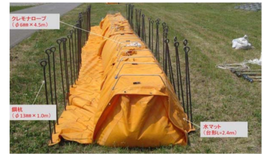
水マット工法
