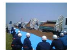
運搬トラックから直接の土砂排土
