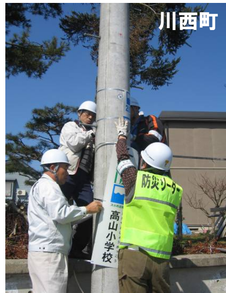
標識の設置状況
