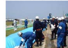
シートが捲くれないように土のうで抑えて完了
