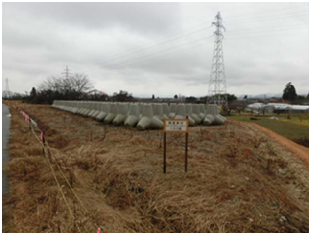
水防資機材の備蓄
