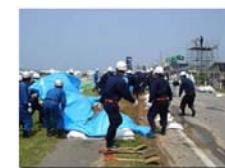
土砂をシートで巻き込む
