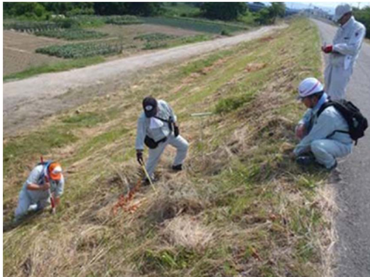
事務所職員による堤防点検
