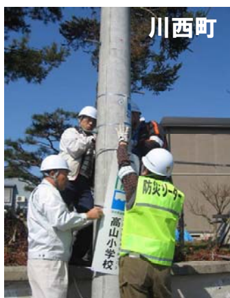
標識の設置状況
