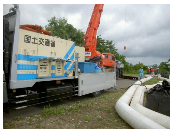
排水ポンプ車設置、排水訓練 (平成 27 年)
