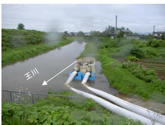
排水ポンプ車による内水排除 (山形市樫沢地区 (H25. 7. 18) )
