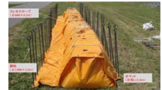
水マット工法
