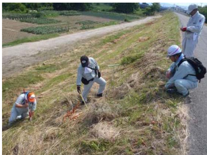
事務所職員による堤防点検
