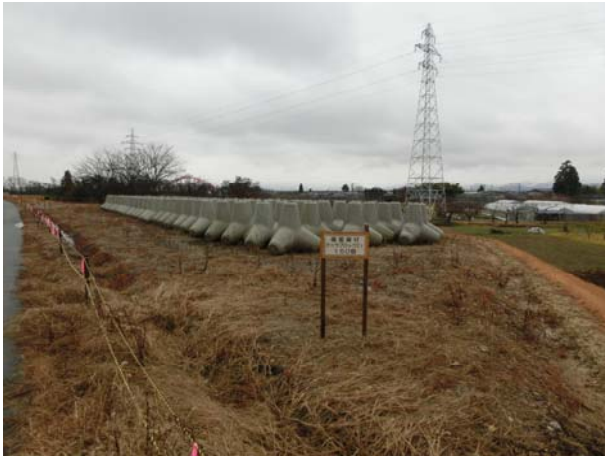
水防資機材の備蓄
